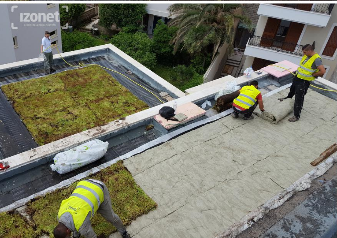
Slike sa našeg gradilišta gdje smo uspješno realizovali ekstenzivni zeleni krov.
